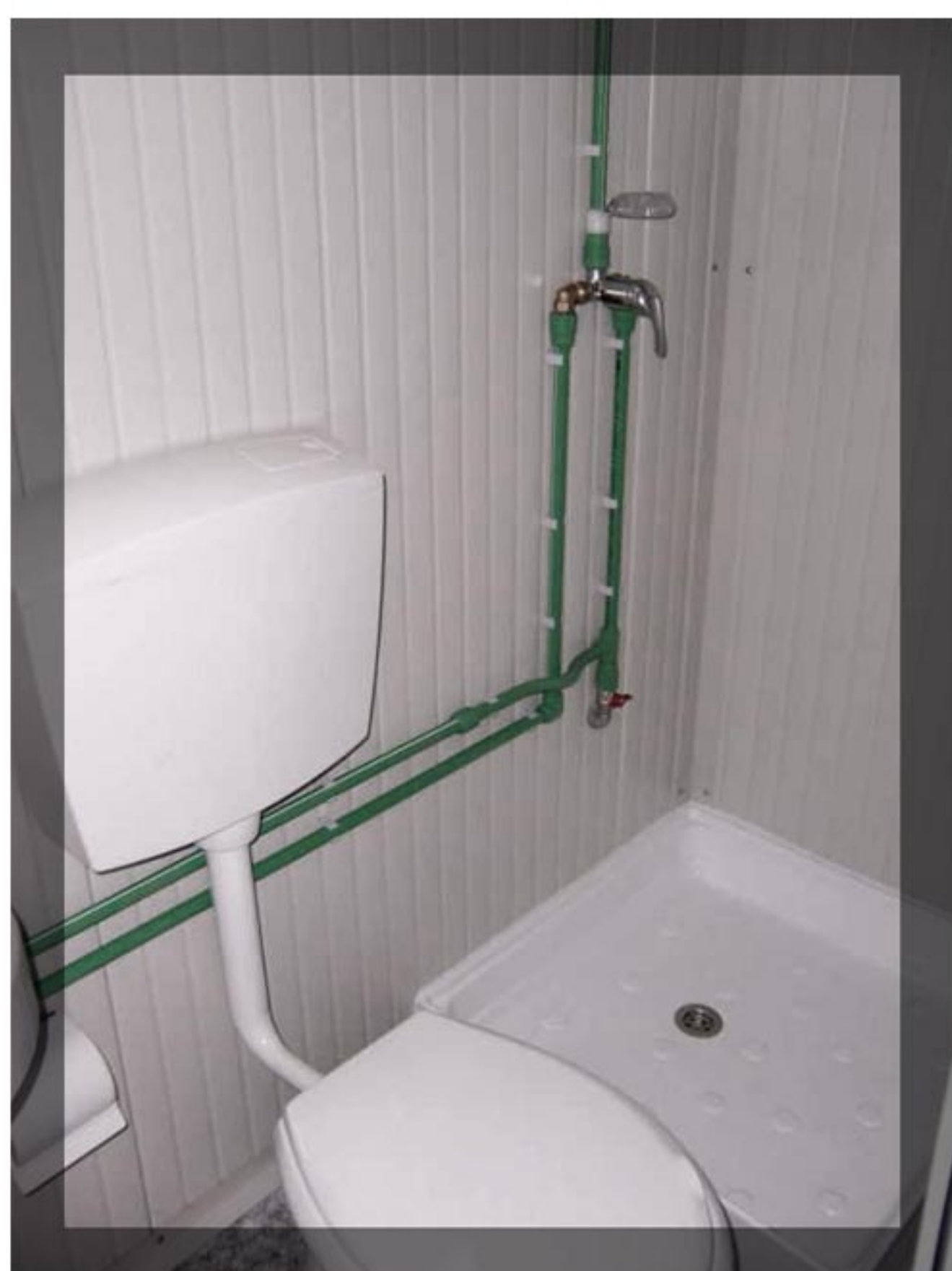
BUNGALOW SANITAIRE AS3 VUE INTÉRIEURE
